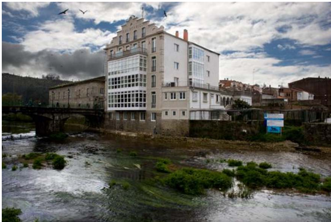
Figura 3.3.- Rehabilitación del Balneario Acuña. Caldas de Reis.
