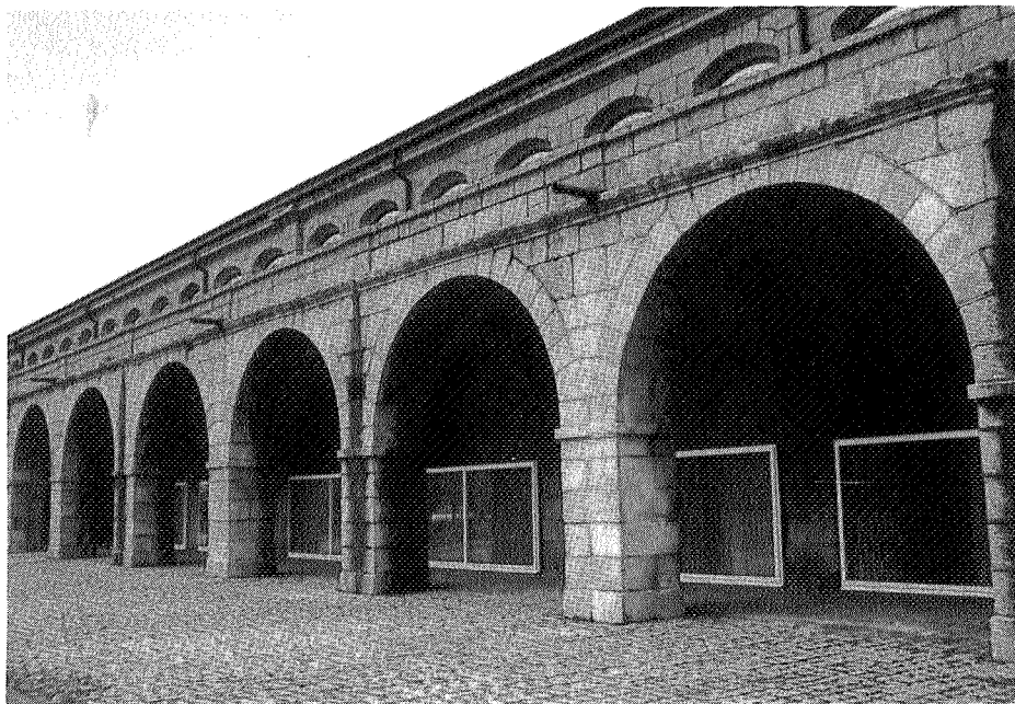
Fig. 4.—Pórtico Este rehabilitado.
