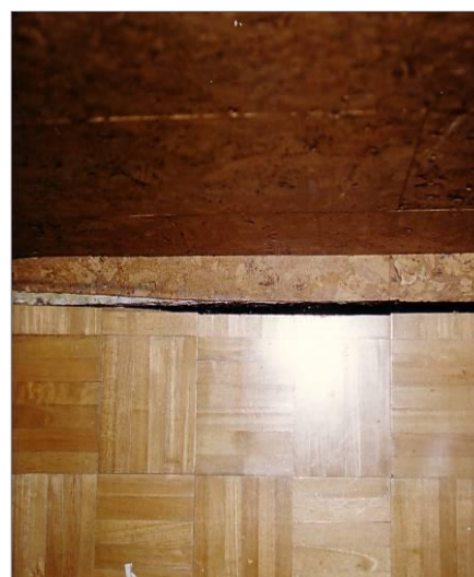
FIGURA 1: El giro en el apoyo está impedido por la fábrica superior y aparecerán momentos negativos superiores a los previstos para un simple apoyo y la armadura inicialmente proyectada resultará insuficiente.
