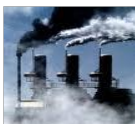
Contaminación CO 2 y sales
