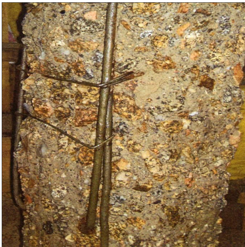
Pilar en sótano de edificio con vestigios de áridos de playa y Conchas de moluscos en la c/Plá y Cancela de Coruña (1946)
