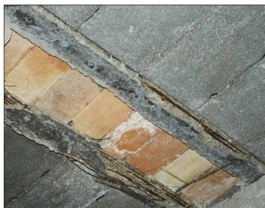
Ejemplos de ataque químico sobre el cemento de las viguetas (Ferrol),
