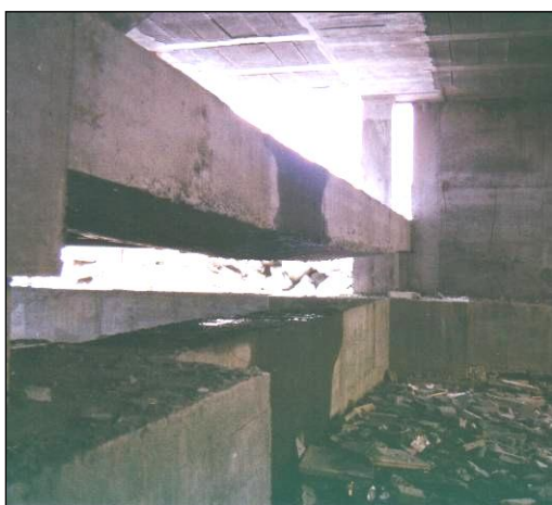
POSIBLES DAÑOS EN EL FORJADO POR FALLOS DE LOS PUNTALES.
