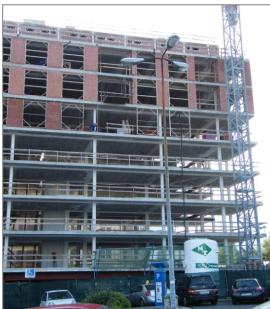
Ejecución correcta de tabiquerías
