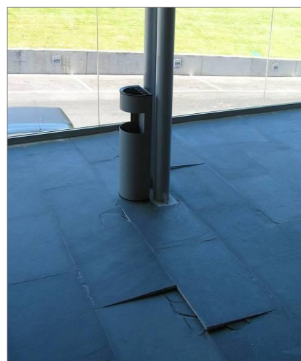
FIGURA 2: Error al proyectar los forjados sanitarios como tramos aislados y simplemente apoyados en los muretes sin especificar el empleo de viguetas autoportantes. No existe armadura para absorber el momento negativo indicado.
