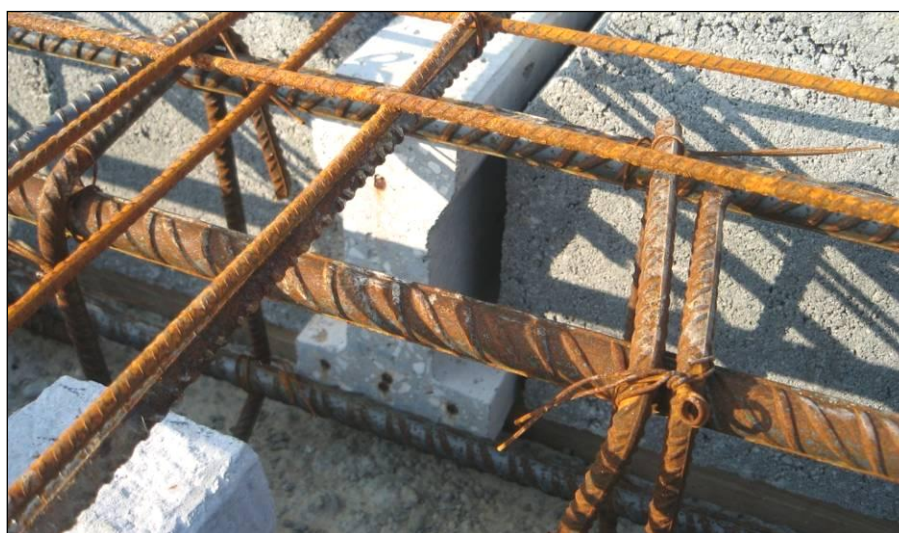
Ejemplo de bovedilla inadecuada a la vigueta en Coruña
