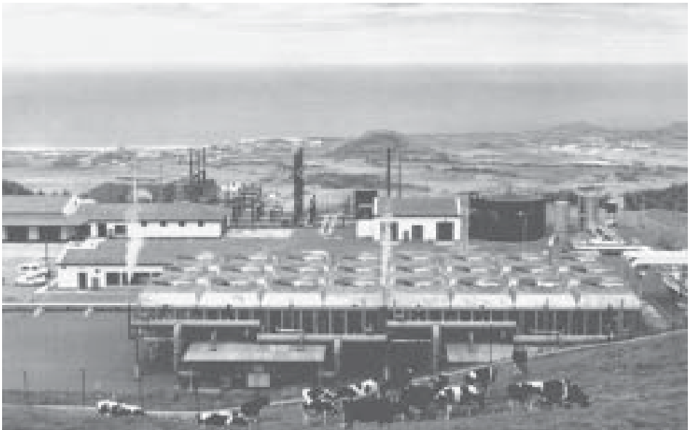
Figura 2. Central geotérmica da Lagoa do Fogo, ilha de S. Miguel, Açores (SOGEO, S.A.).
