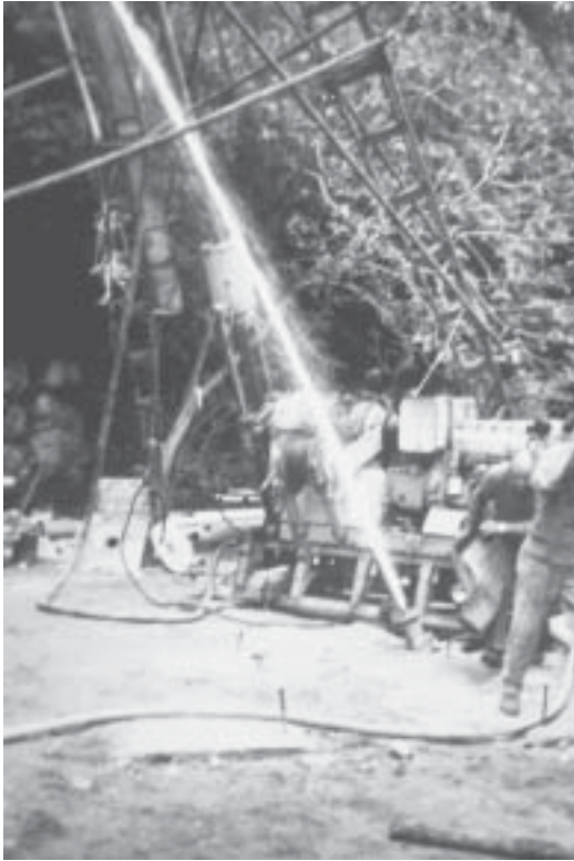
Figura 8. Prospecção de fluidos termominerais em Manteigas (Serra da Estrela, Portugal Central).
