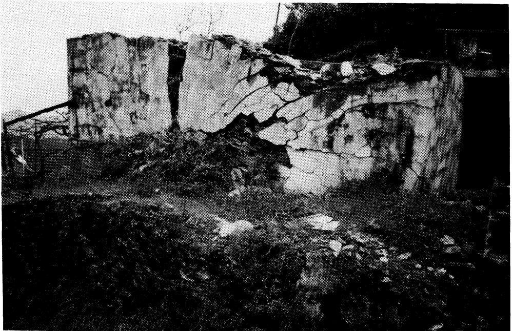
Fig. 3. Efeitos de uma descontinuidade (« Quebra Vertical ») numa habitação na área de Germunde (perfil S de subsidências).
