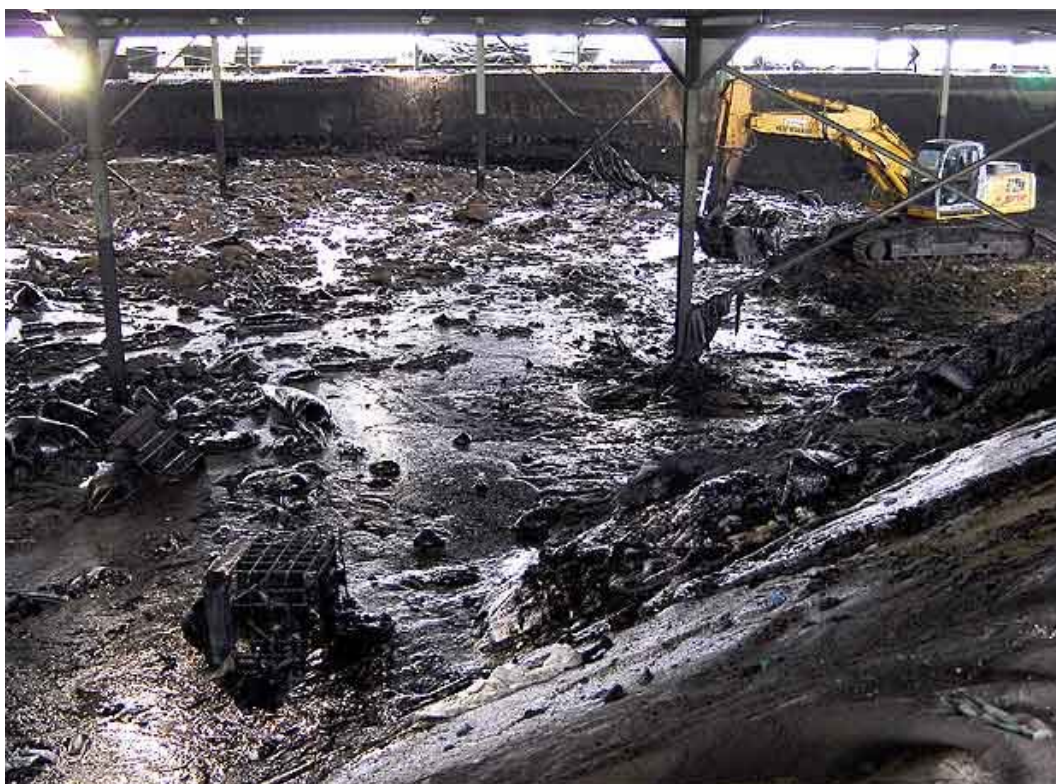
Figura 5.6. Balsa de almacenamiento de los residuos de fuel del Prestige. SOGARISA, As Pontes.
