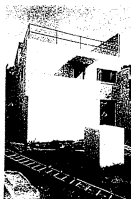
THEO VAN DOSSBURG Casa estudio en Mouton-ras-Picury Vista exterior. Fotografía tomada durante las obras a principios de 1930
