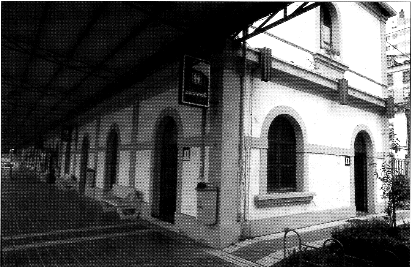
DETALLE DA ACTUAL ESTACIÓN DO FERROCARRIL DE LUGO, EDIFICIO HERDEIRO DO PROXECTADO EN 1873 POLO ENXEÑEIRO J OAQUÍN LÓPEZ DE LETONA.
