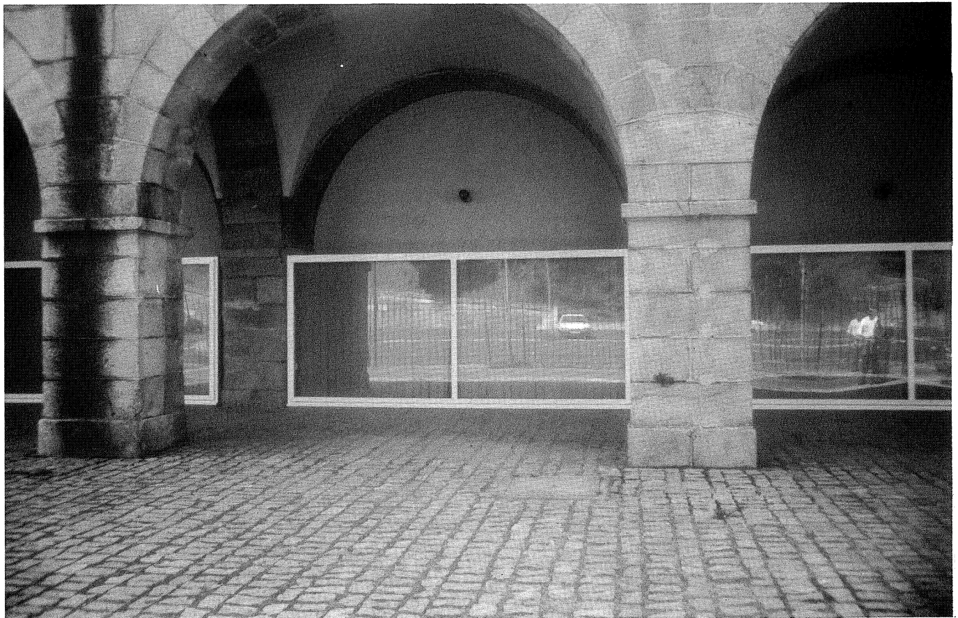
11.—DETALLE DEL PORTICO ESTE.
