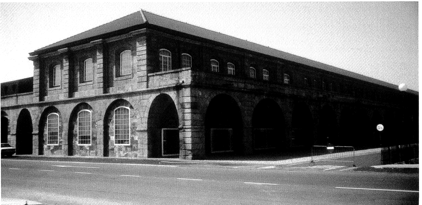
7.—FACHADA SUR DEL EDIFICIO DEL GRAN TINGLADO REHABILITADA.
