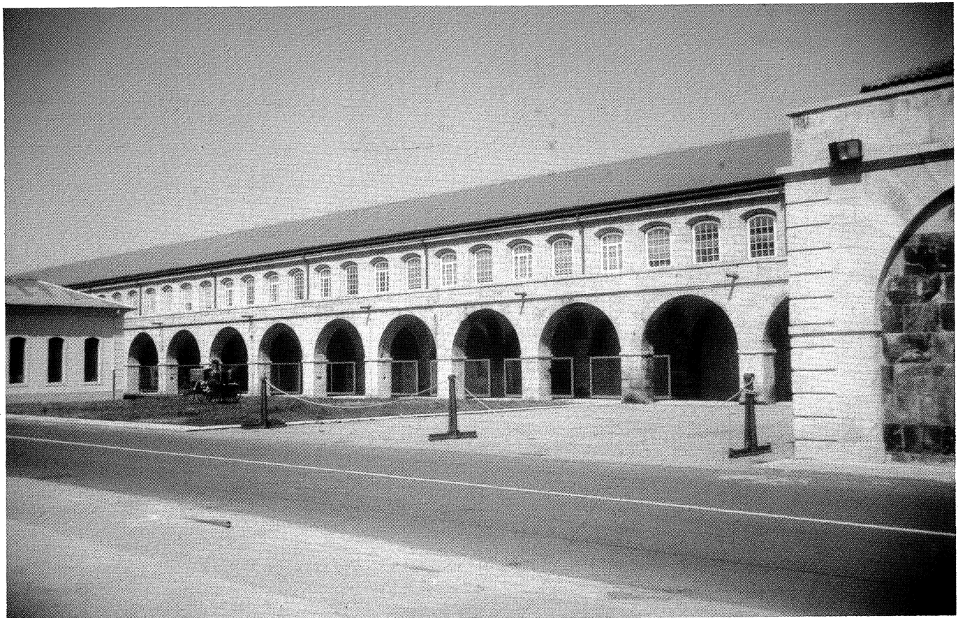
9.—FACHADA OESTE DEL EDIFICIO DEL GRAN TINGLADO REHABILITADA.
