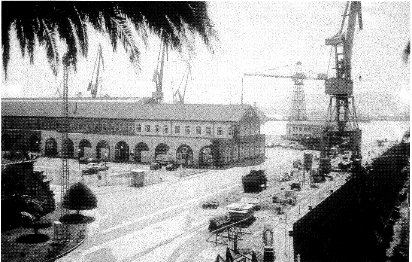
13.—FALSA FACHADA DEL EDIFICIO DEL GRAN TINGLADO PROYECTADA POR CIRICI Y BASOLS PARA RESOLVER EL CORTE PRODUCIDO CON LA CONSTRUCCION DEL DIQUE DE LA REINA. VISTA DESDE LA POPA DEL DIQUE.
