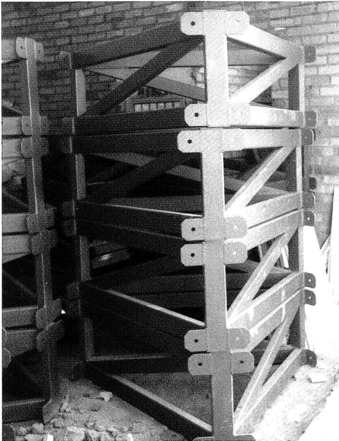
Fig. 11.—MÓDULOS ENSAMBLABLES DE LA CUBIERTA DEL AUDITORIO DE LA RABIDA.
