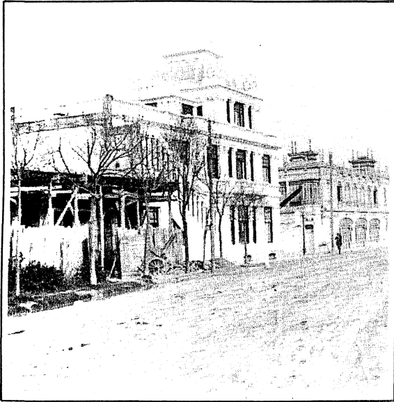
Fig. 33.—EL EDIFICIO DE «LA TERRAZA» EN OBRAS EN 1921. LA IMAGEN DEFINITIVA DE LA CONSTRUCCION OBEDECE A LAS REFORMAS INTRODUCIDAS EN LOS DISEÑOS DE 1920 DE ANTONIO DE MESA POR EL ARQUITECTO PEDRO MARINO.
