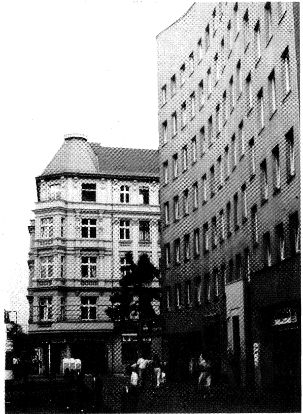
4.— El edificio de Siza Vieira del bloque 121 frente a uno ya renovado.
