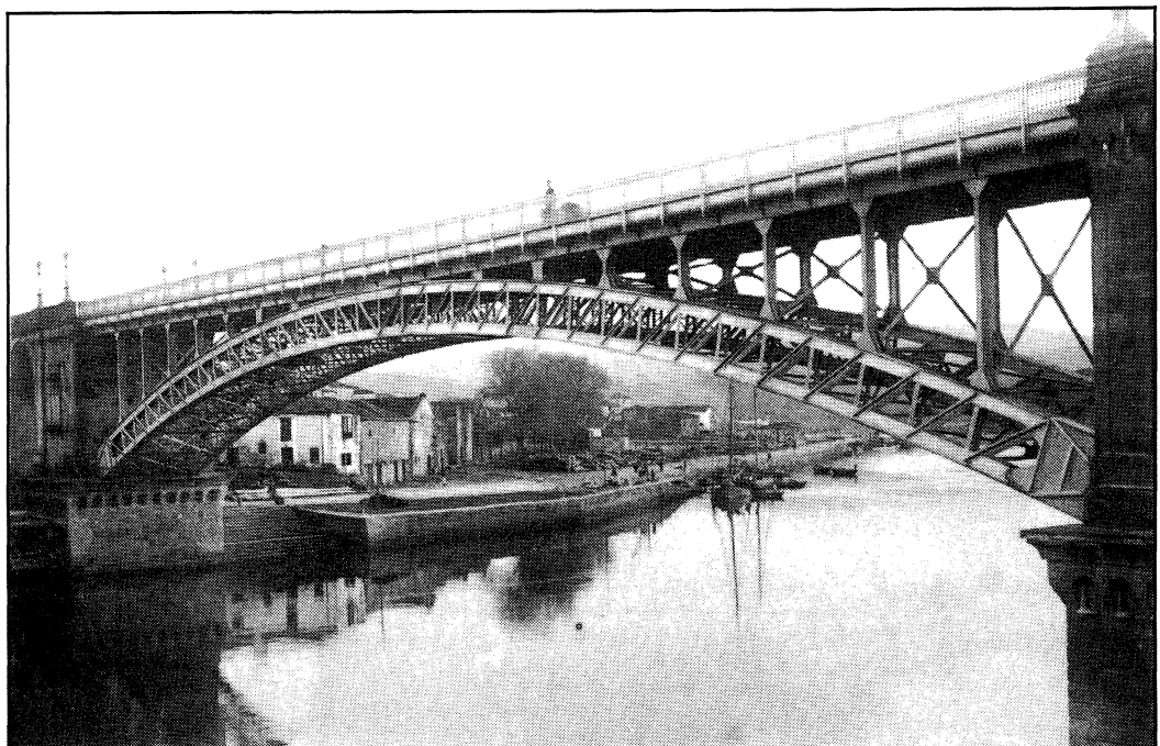
PUENTE DE HIERRO DE LA BARCA, PONTEVEDRA. CONSTRUIDO A FINALES DEL SIGLO XIX, ESTRUCTURA METALICA ORIGINAL, HOY SUSTITUIDA POR OTRA SIMILAR DE HORMIGON ARMADO.
