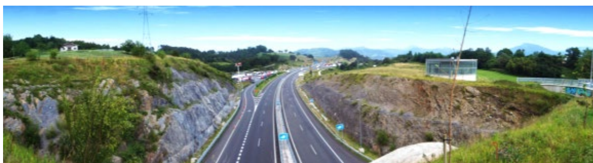
Figura 1.- Vista general del tramo de vial estudiado.
