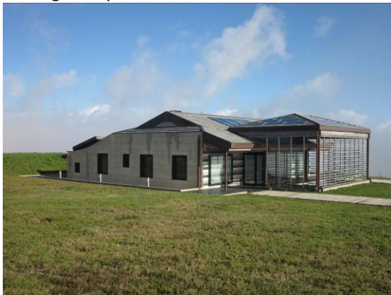
Vista sur oeste. Sistemas de climatización solar por galería invernadero y muros trombe. Sistemas solares térmicos y fotovoltaicos.
