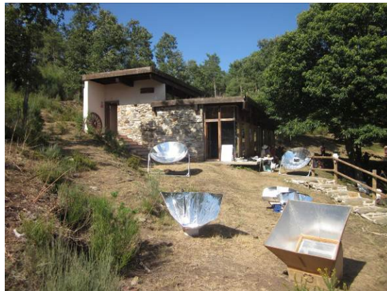
Árboles de hoja caduca frente a la fachada acristalada orientada al sureste, la sombra proyectada impide el sobrecalentamiento en verano, en invierno dejan pasar el sol. Hornos y cocinas solares.
