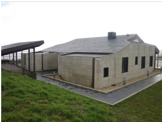
Vista noroeste. La fachada norte no dispone de huecos, minimizando las pérdidas térmicas. Cubierta de pizarra, propia de la construcción tradicional del entorno.
