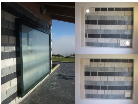
Muro trombe en la fachada sur. Interior: conductos abiertos para favorecer la entrada de aire caliente en invierno. En verano se cierran los conductos y se abren unas trampillas de ventilación en el exterior.
