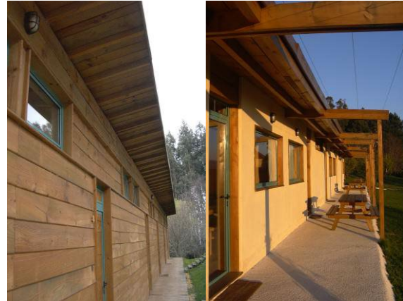
La fachada sur busca captar el máximo de aportación solar para climatizar el interior. La norte busca minimizar las pérdidas térmicas disminuyendo el tamaño de los huecos e incrementando el aislamiento
