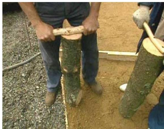
Apisonado de solera de barro sobre capa de concha de mejillón (Dimarca). Fuente: www.baubiologie.at
