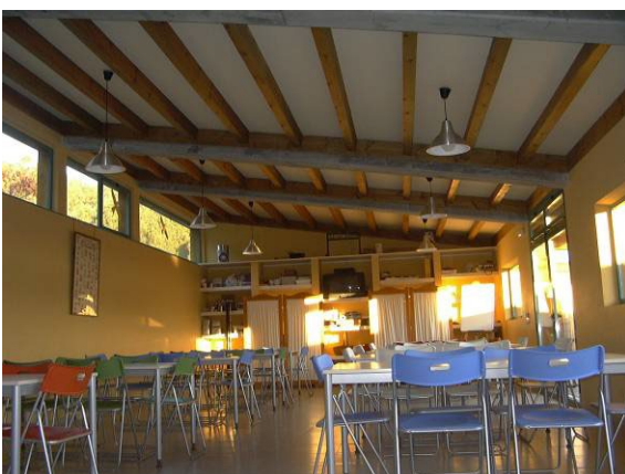
Instalaciones comunes: pavimento de linóleo, paramentos transpirables, pinturas no tóxicas, madera estructural
