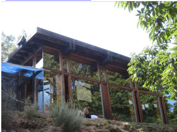
Acrilamiento en la fachada orientada este-sureste. Alero en la cubierta.
