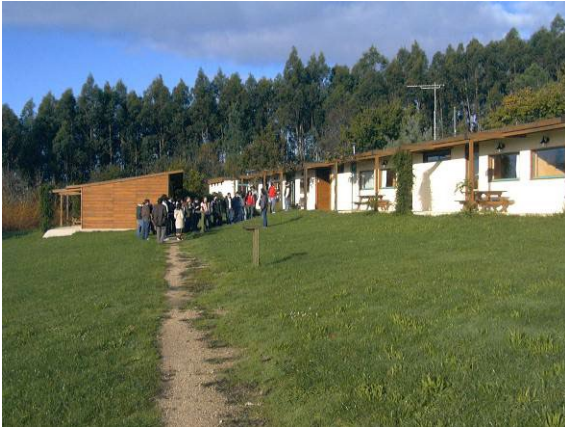
Disposición de los edificios buscando el mayor soleamiento posible. En la fachada sur, ventanas amplias, una dimensión correcta del alero permite que la ventana esté soleada en invierno pero no en verano.
