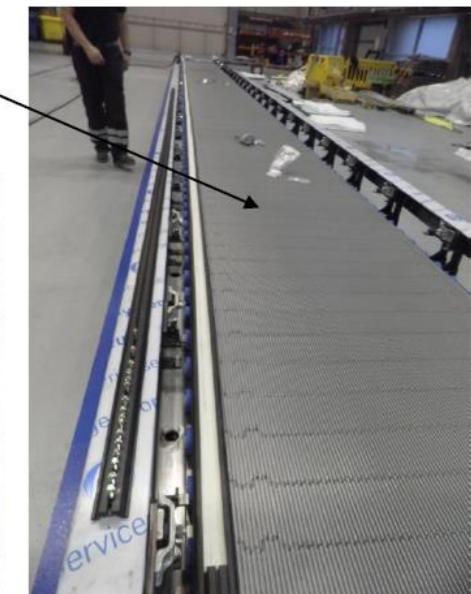
Una vez unidos todos los tramos, antes de instalar ningún otro material, hemos de proceder a nivelar y alinear con precisión y a apretar con llave toda la tornillería de unión.
