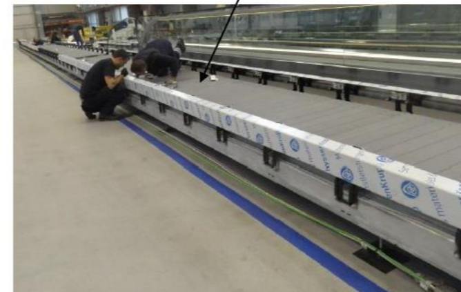
Una vez unidos todos los tramos, antes de instalar ningún otro material, hemos de proceder a nivelar y alinear con precisión y a apretar con llave toda la tornillería de unión.
