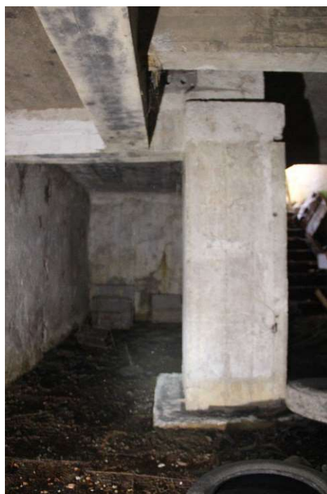
Fig. 40 Estado actual del refugio
