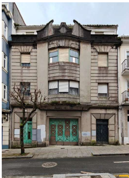
Fig. 39. Fachada actual del edificio
