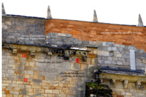
Fig. 8. Vista del engarce entre la cabecera y la fachada norte de la iglesia. Imagen de los autores
