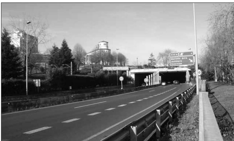
Paso de la Autovía del Cantábrico por Astillero. C. N.
