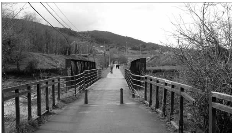
Cruce de la ría de Solía del ferrocarril Astillero-Ontaneda, hoy transformado en Vía Verde. C. N.
