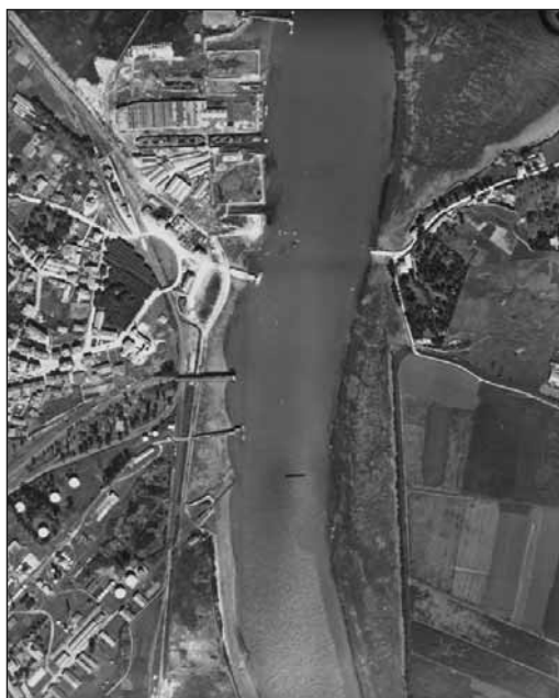
Fotografía aérea de los Talleres de Astillero, herederos de Bernardo Lavín, en 1946. Instituto Geográfico Nacional (IGN).
