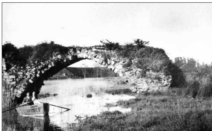
El Puente de Solfa, con la única bóveda que conservaba, antes de la restauración en los años 90. Archivo Municipal de El Astillero.
