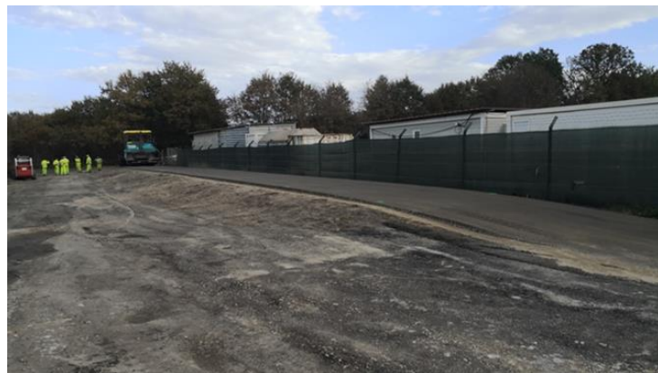
Figura 11: Colocación de la capa intermedia (MBC tipo AC 22 bin D).
