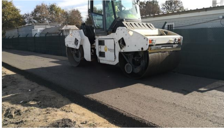
Figura 10: Compactación de la capa de base 1 empleando un rodillo metálico.
