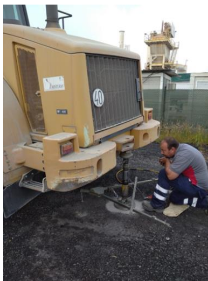
Figura 6: Medición del módulo de compresibilidad con el ensayo de carga con placa , para determinar la capacidad portante del suelo : en este caso se trata de una explanada E1 (superior a 60 MPa; Ministerio de Fomento [5]).
