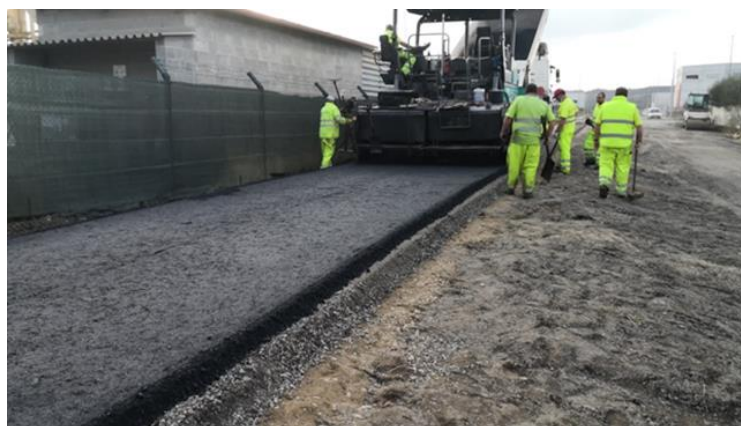
Figura 12: Extendido de la capa de rodadura (MBC tipo AC 16 Surf D).
