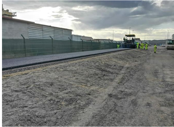
Figura 13: Vista general del tramo de prueba-prototipo una vez finalizado .
