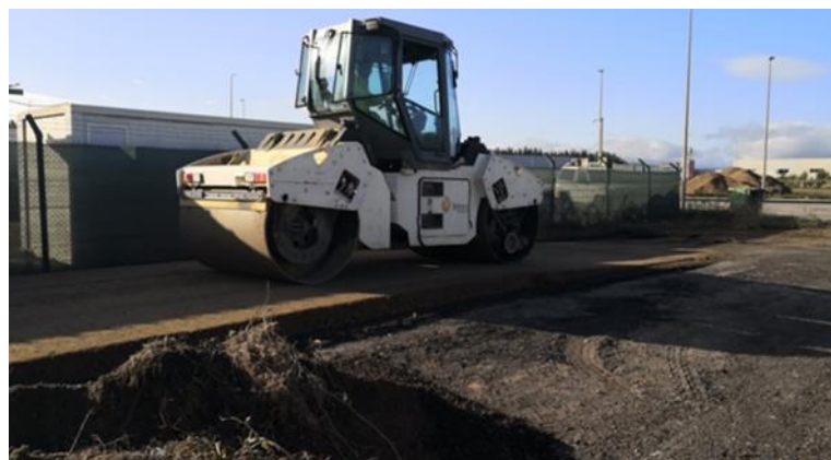
Figura 8: Colocación de la capa de subbase (foto superior) y de la base , constituídas por zahorras. La foto inferior muestra el proceso de compactación de las capas empleando un rodillo metálico.
