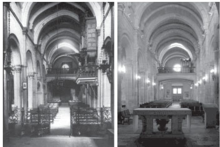
Fig. 09. Colegiata de Santa María del Campo, A Coruña, s. XII; exterior; estado inicial y renovación litúrgica del presbiterio y de la nave. Santiago Fernández y Rafael Taboada (abades), 1967 ss.
