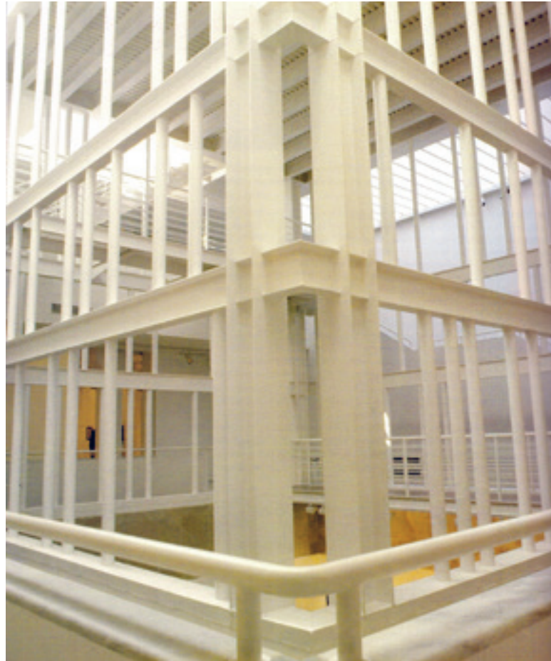
[Fig. 11] Fotografía del vacío interior del Centro Atlántico de Arte Moderno en Las Palmas. Fuente: Torres, Sáenz de Oíza, 52.
