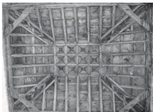
Figura 4 Imagen de la cabecera de la iglesia de Santiago de Estraxiz, en Samos. Luz de 4,5 m (imagen del autor)
