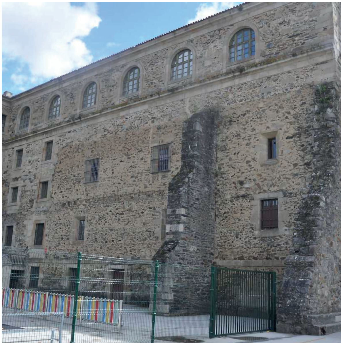
Figura 6. Vista parcial de la fachada del edificio hacia el río en la que se diferencia la parte construida en el s. XVII de la ampliación del s. XX.
