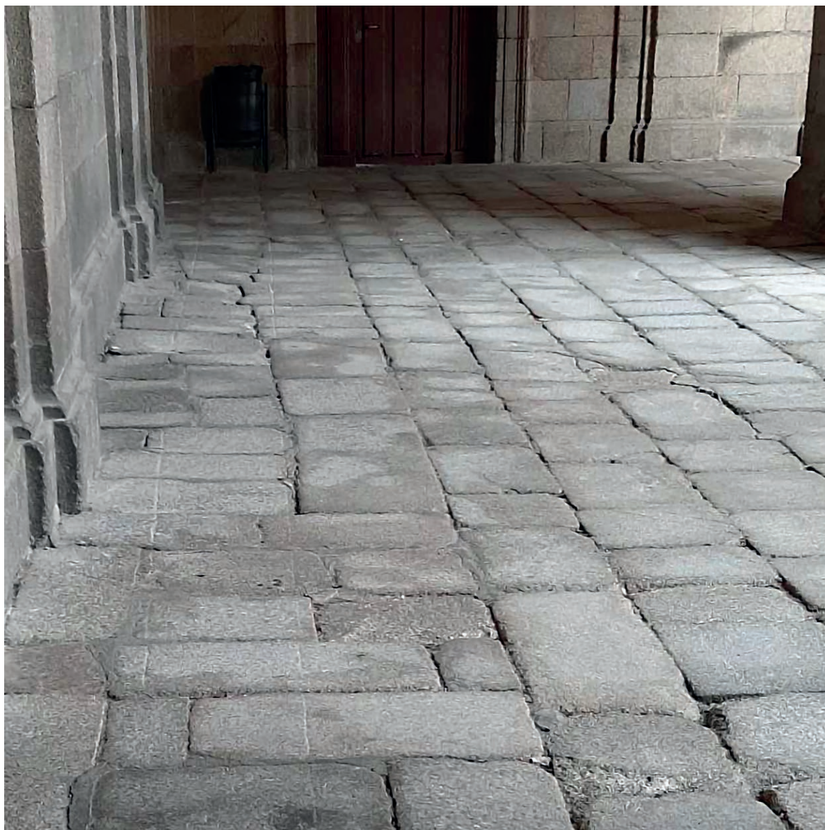
Figura 15. Trazados cincelados en el enlosado del acceso a la iglesia.
