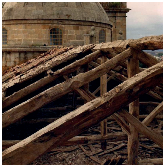
Figura 10. Estructura de madera original de la cubierta de la Iglesia (Cortesía de A. Rdgz. Domínguez).
