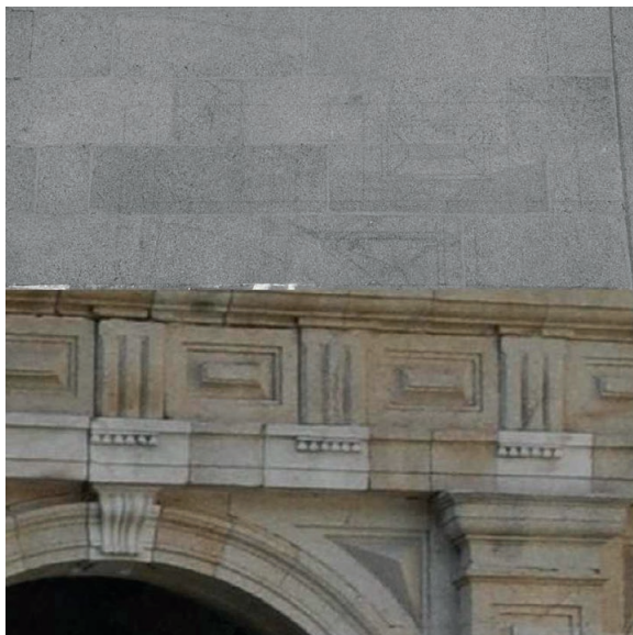
Figura 12. Trazados de monte de las enjutas y metopas de la arquería del Claustro Mayor y su correspondencia con la realidad.
