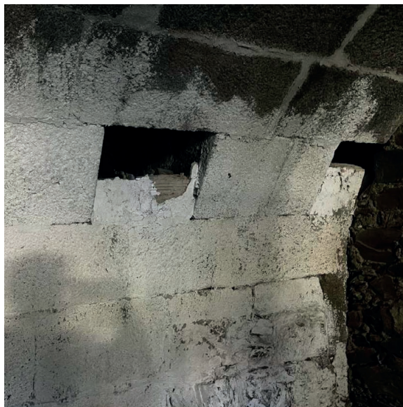
Figura 9. Huecos de ventilación en las bóvedas del semisótano.
