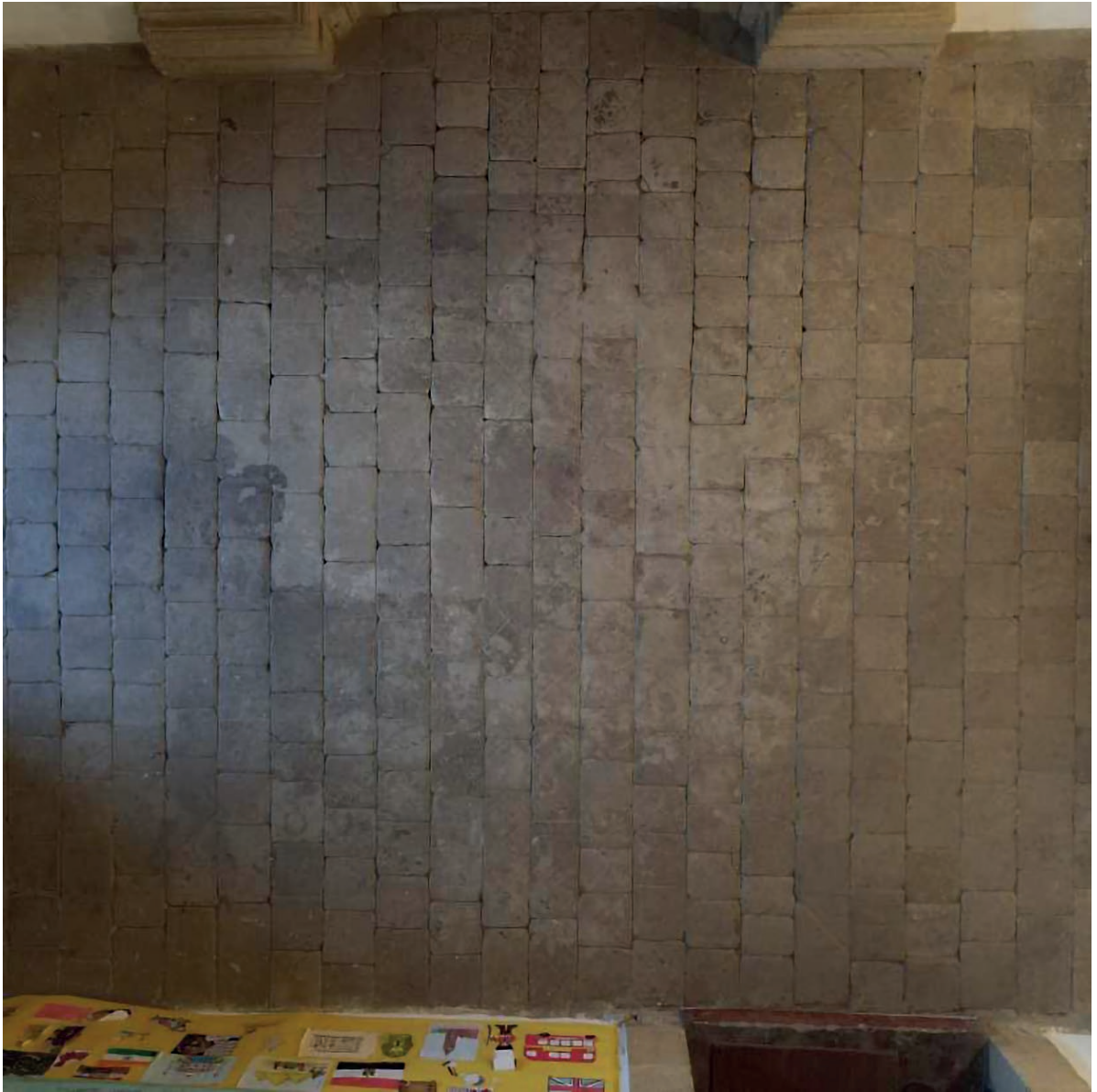
Figura 16. Trazados cincelados en el enlosado de la antesacristía.
