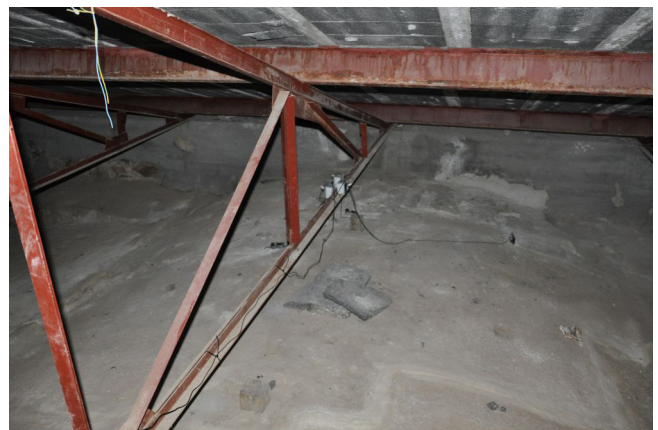
Figura 13. Sistema de registro instalado.
