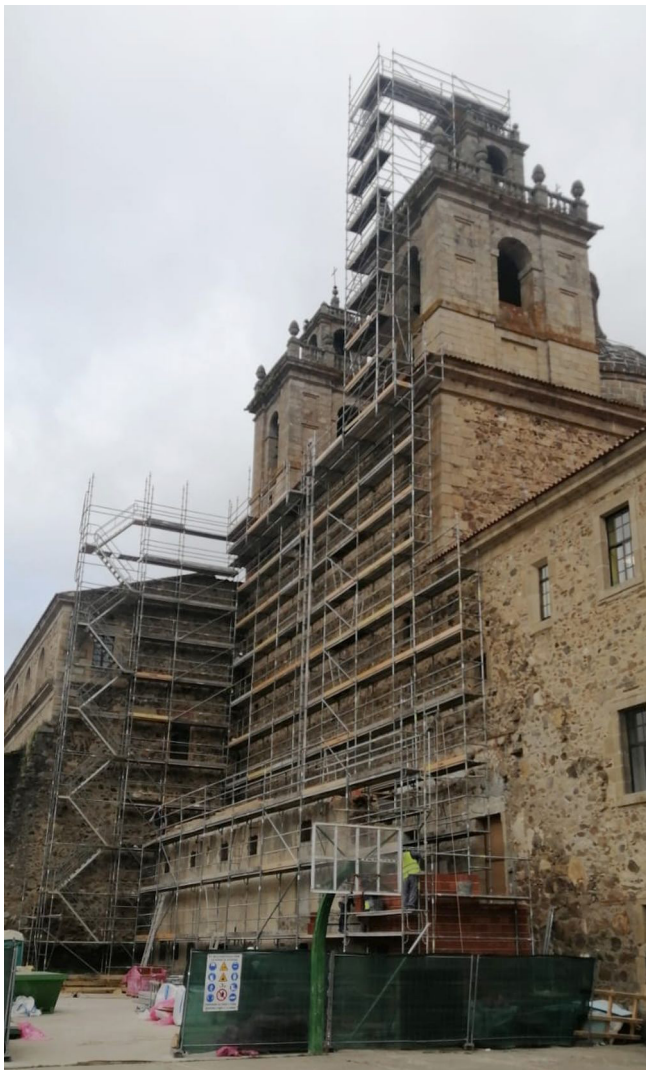
Figura 12. Sistema de andamios situado en la fachada hacia el río Cabe..
