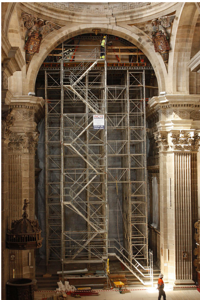
Figura 9. Plataforma de trabajo y estructura de soporte (cortesía S. Pereira).
