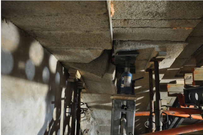
Figura 11. Preparación para el empuje de las dovelas del arco de cierre de la bóveda.
