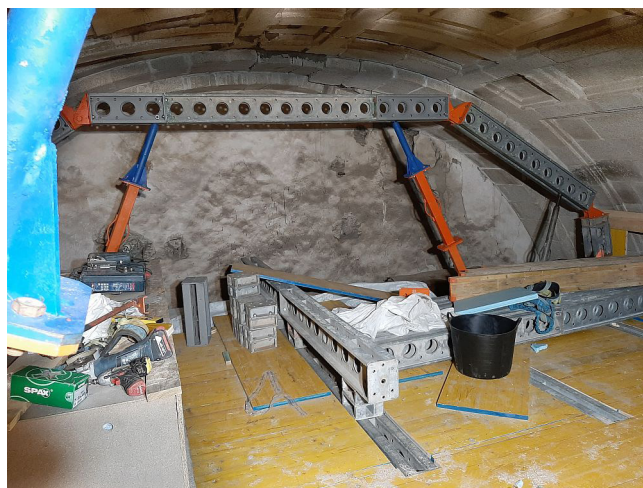
Figura 10. Formación del nivel superior de la plataforma de trabajo.
