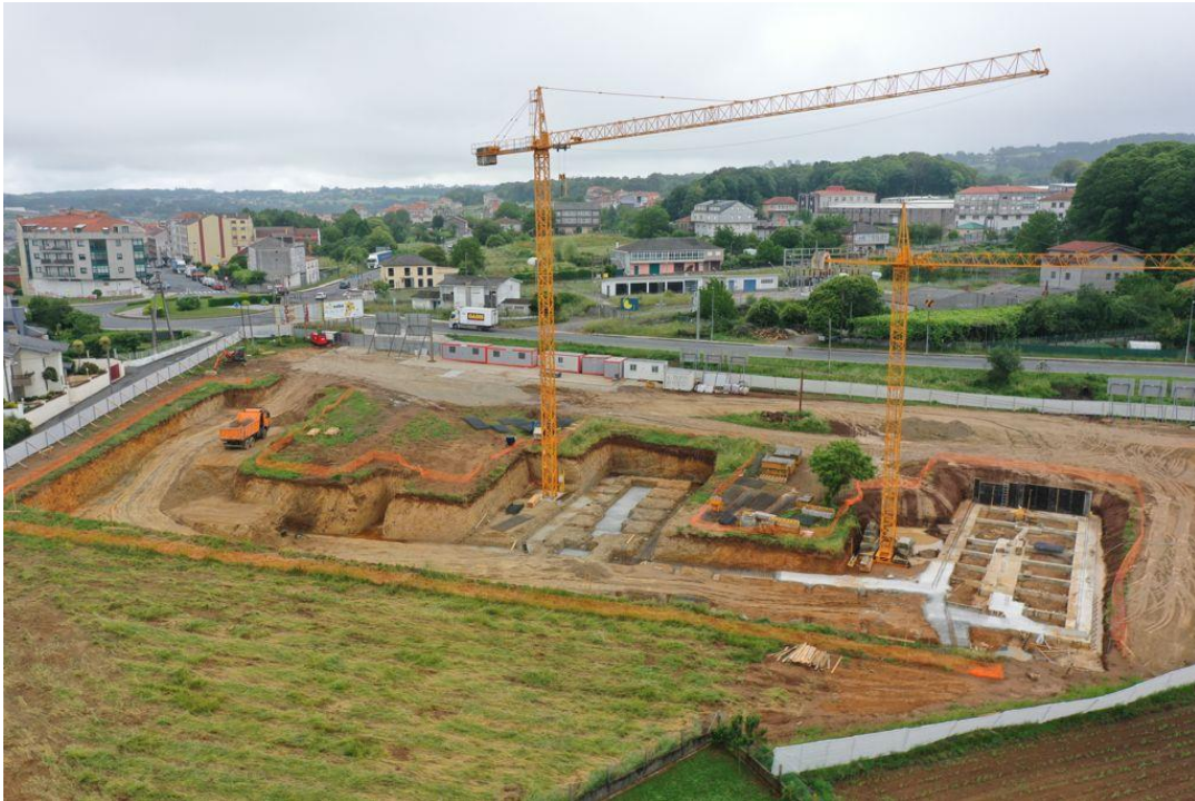
Imagen 32: Vista aérea cimentación C.I.S.
