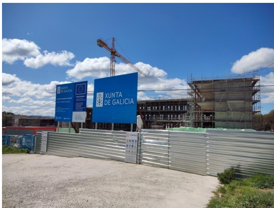
Imagen 34: Acceso a la obra.
