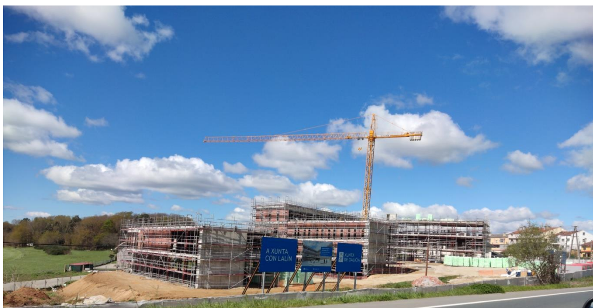
Imagen 35: Ejecución estructura C.I.S. Fachada Noreste
