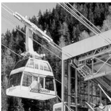
Teleférico de vaivén Samnaum (récord del mundo con cabina de 180 plazas en dos pisos). Fabricante: Garaventa
