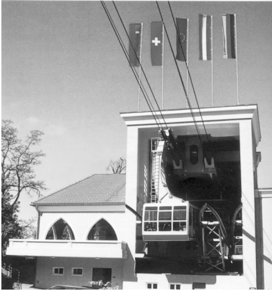
Estación del teleférico de Bregenz (Austria). Las cabinas de gran capacidad obligan a estaciones de considerable tamaño. Fabricante: Doppelmayr
