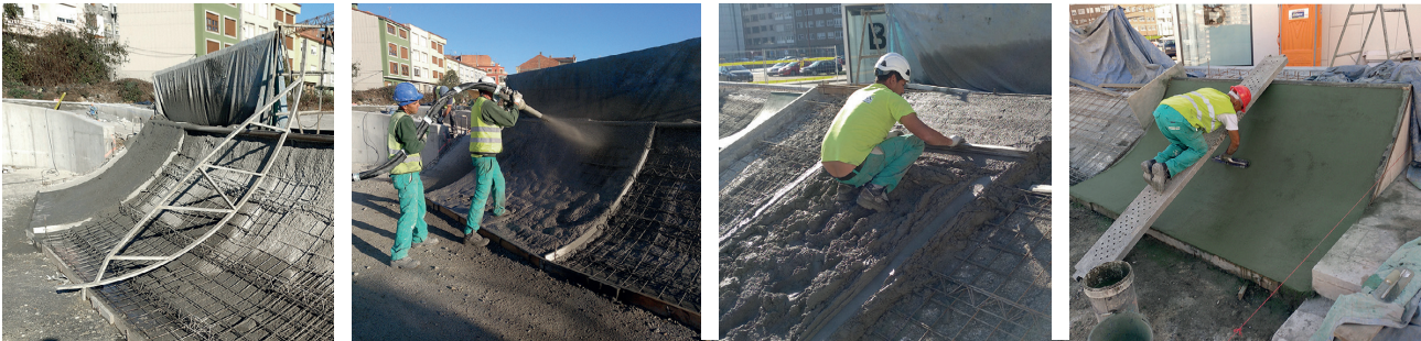
Figure 5. Curved ruler to set out the surface, application of the gunite (two operators counteract the pressure exerted by the pump) and flattening after the application of silica sand / Figura 5. Regla curva de replanteo de la superficie, aplicación de la gunita (dos operarios contrarrestan la presión que ejerce la bomba), regleteado y llaneado tras la aplicación de la arena de sílice.
