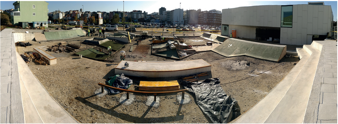
Figure 8. View of the open pit with the trucks ready, before the execution of the cast concrete slab. Skate-plaza Rego da Balsa (Carballo, A Coruña) / Figura 8. Vista del tajo con los trucos ejecutados, antes de la ejecución de la solera. Skate-plaza Rego da Balsa (Carballo, A Coruña).
