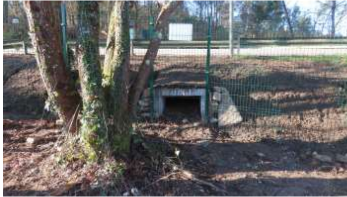
Figura 2: Imagen del paso de fauna, ubicado en la zona de las compuertas del embalse (Fuente: Concello de Cambre; https://cambre.es/inauguracion-del-paso-de-nutrias/?lang=es ).
