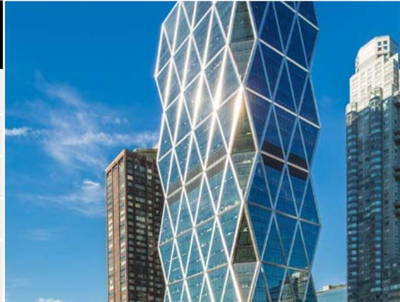
Hearst tower es una de las mejores aplicaciones del sistema diagrid en edificios en altura. Los ángulos, las achaflanadas “bocas de pájaro”, los triangulaciones, etc.
