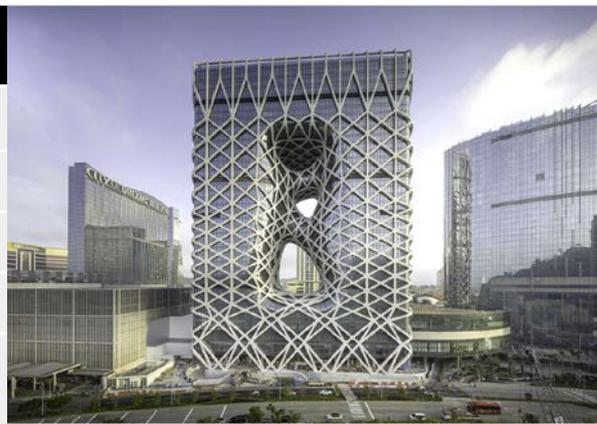
El edificio de una forma irregular sin columnas interiores dio un impulso al desarrollo del diseño paramétrico. El equipo de ingenieros desarrolló durante 4 meses unas herramientas informáticas para poder resolver la complejidad del sistema. Una forma de proyectar diferente a lo visto anteriormente.
