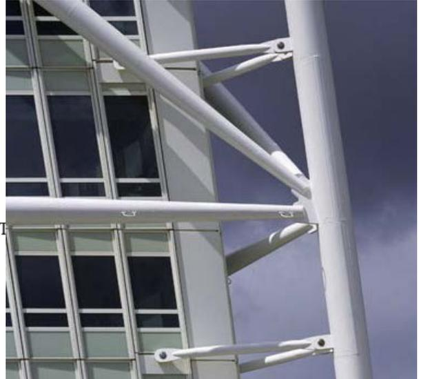
*Fig 19. Imagen del cordón principal del exoesqueleto y sus elementos de conexión con los forjados.*
