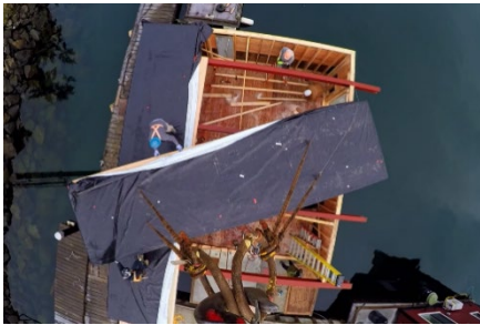
FIG 61: Exemplo obra realizada in situ
