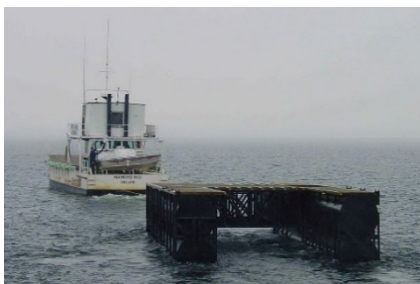
FIG 66: Exemplo pontón metálico
