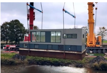
FIG 60: Exemplo obra prefabricada
