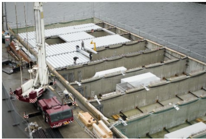
FIG 63: Fabricación pontón de formigón
