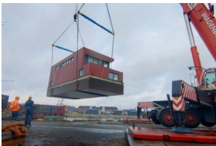
FIG 59: Exemplo obra prefabricada
