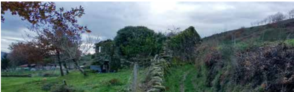
Vista de la fachada este desde el camino público
