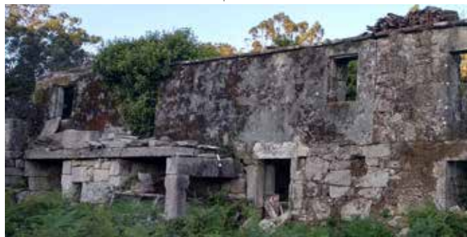
Patín y espacio debajo del mismo de acceso a cuadras y gallinero
