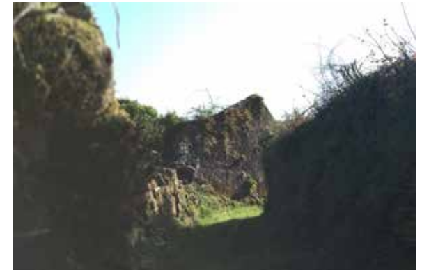
Fig. 12 Fachada norte ruinas, 2021 (Fotografía de la autora)
