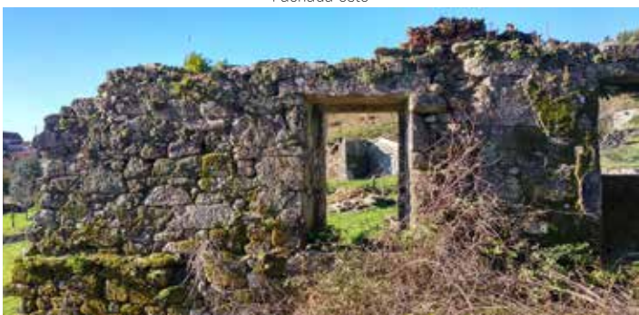
Vista interior del muro oeste al sur
