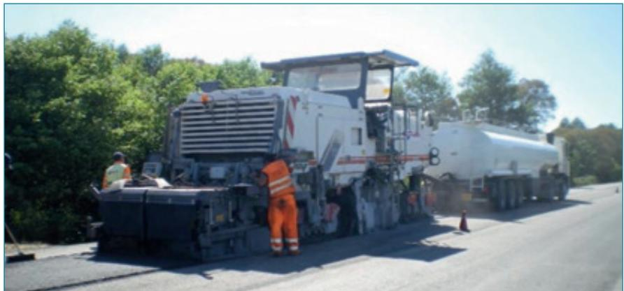
**Foto 1.** Ejecución de un CIR. Fotografía facilitada por la Asociación Técnica de Emulsiones Bituminosas, ATEB.
