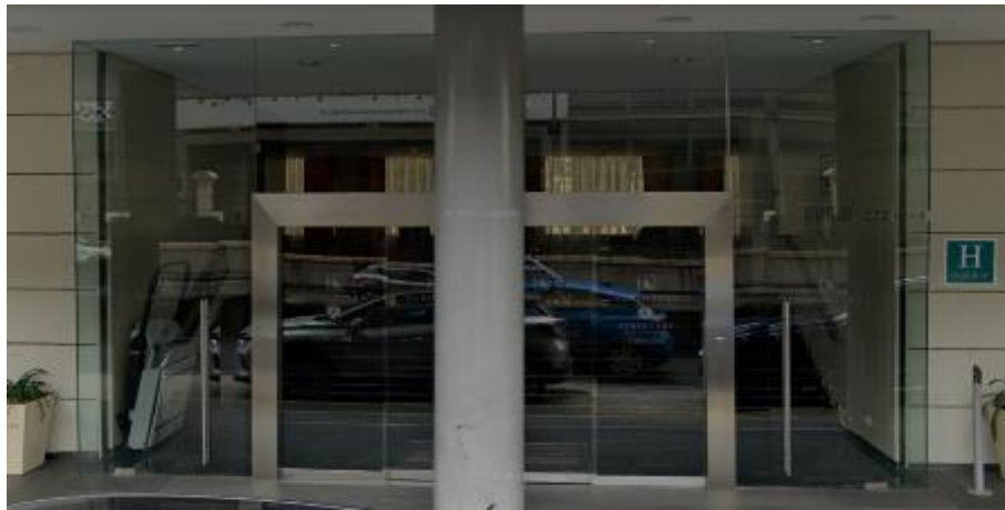
Figura 27. Entrada de un hotel en A Coruña
