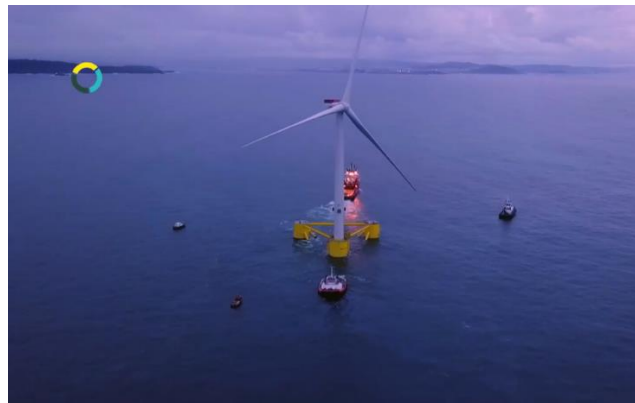
Figura 4.3.4: Remolque da unidade ensamblada á localización offshor (NAVANTIA, 2021)
