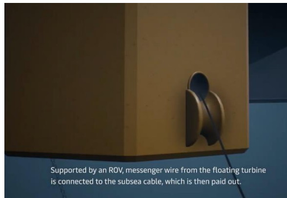
Figura 4.4.1. : Mensaxeiro da estrutura eólica para ser conectado ao cable eléctrico (MAERSK, 2020)
