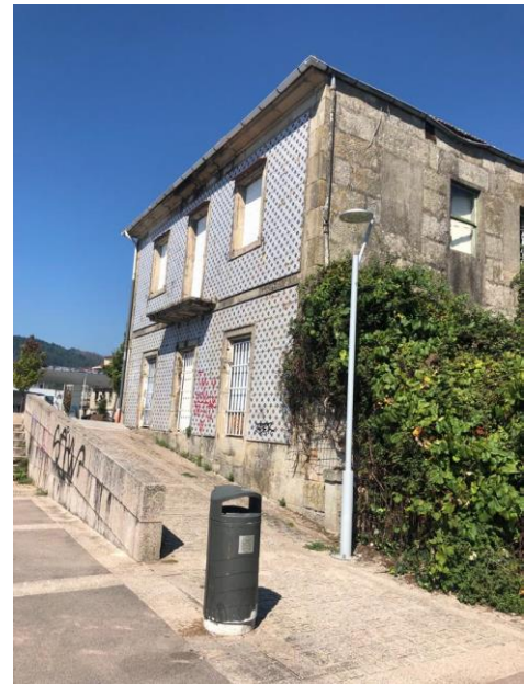
F0 1-Viviendas existentes en la parcela
