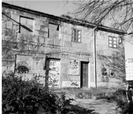
Fig.6 Estado actual de la fachada de las dos viviendas a rehabilitar
