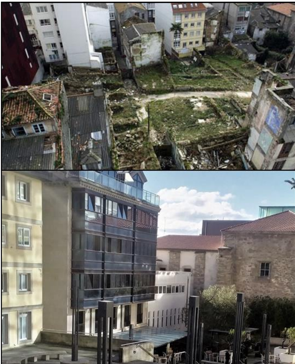
Imagen 6.2.2. Barrio del Papagayo antes y después de su rehabilitación
