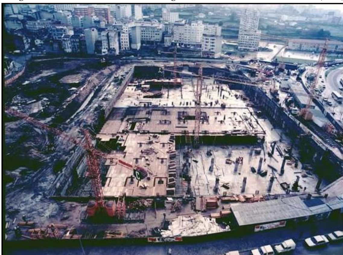
Imagen 1.2.1. Construcción del Corte Inglés en A Cubela-Cuatro Caminos (1984)
