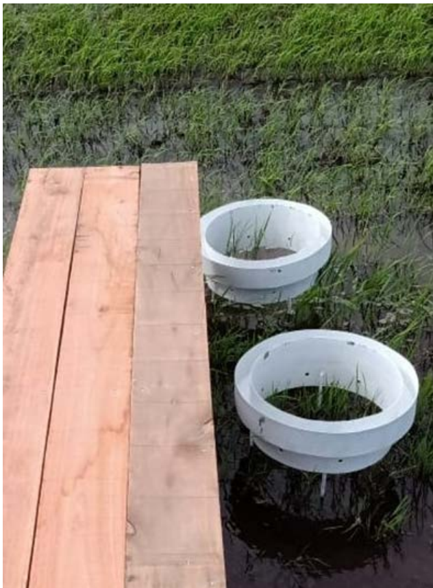
Figura 4-29: instalación de las bases metálicas para apoyo de las cámaras.
