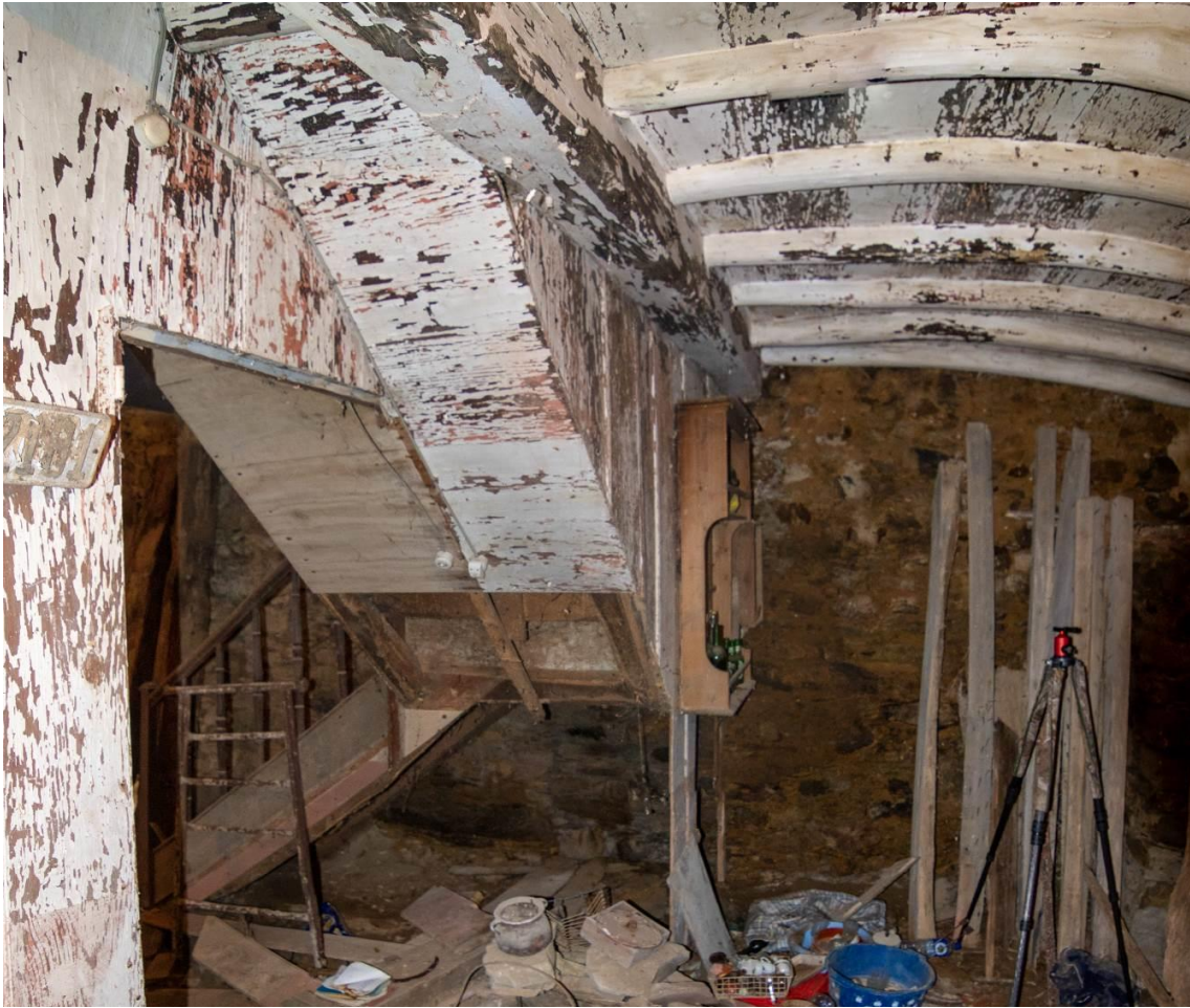
Imagen 16: Escaleras planta baja a planta primera.
