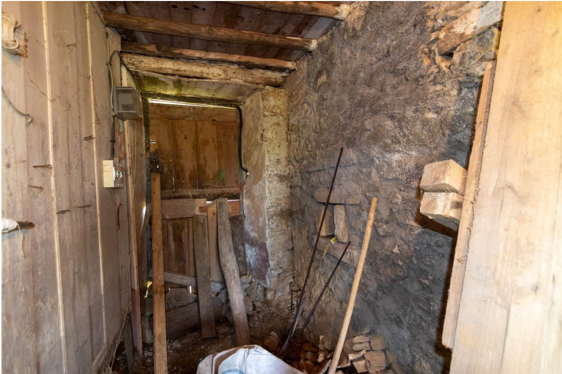
Imagen 12: Puerta a la fachada sur en planta baja.
