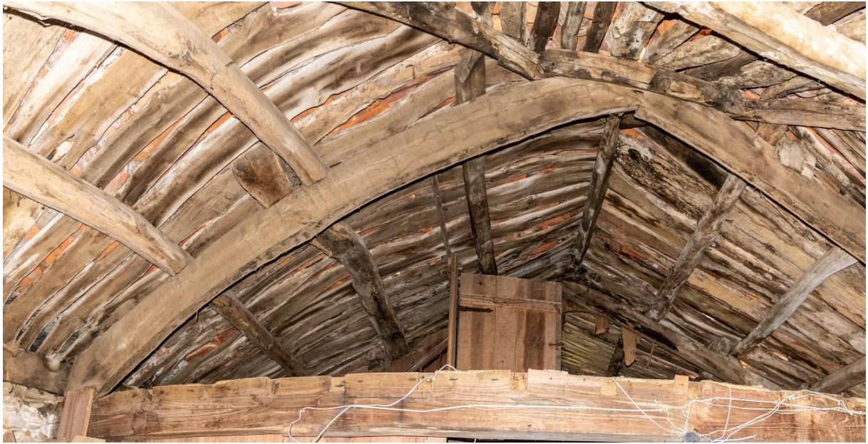
Imagen 18: Estructura de cubierta.
