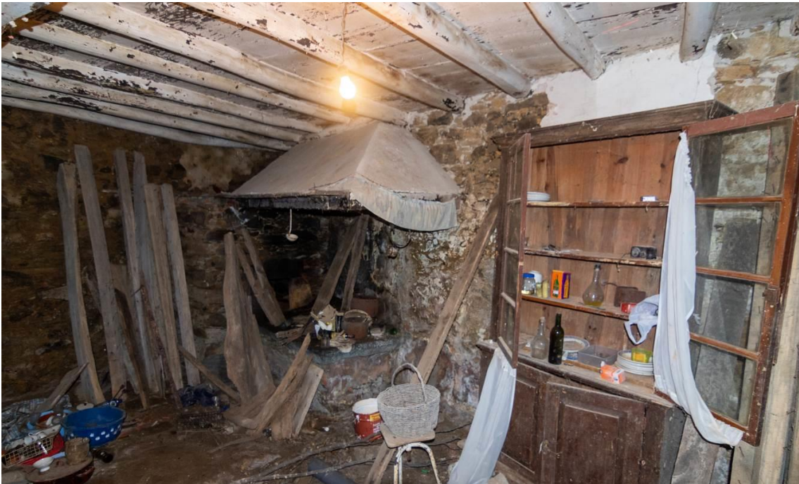
Imagen 15: Cocina existente en planta baja.
