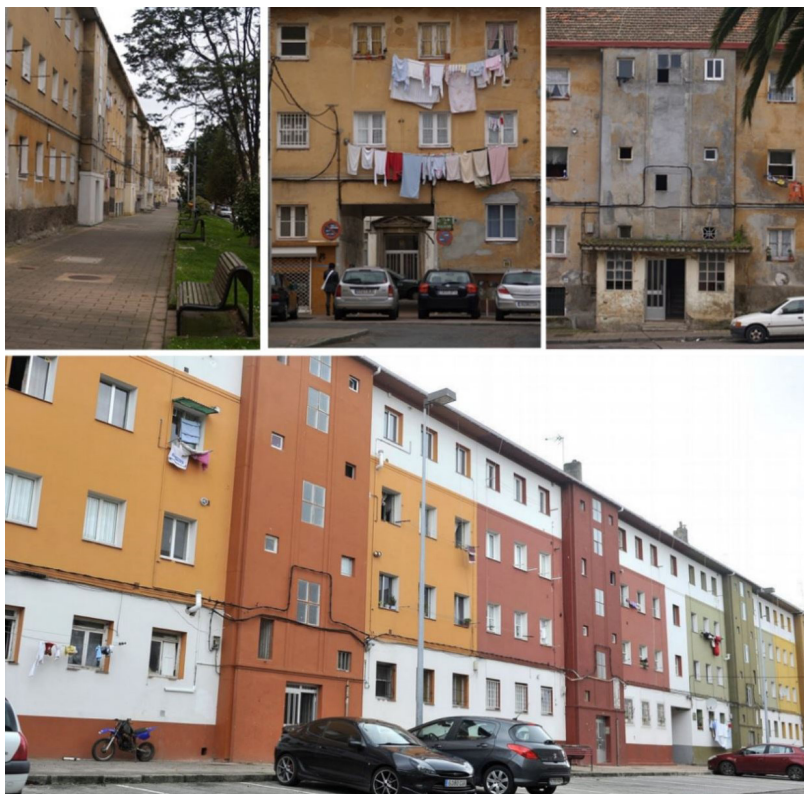
Figura 2. Fachadas de Recimil sin rehabilitar en el año 2016 (arriba) y rehabilitadas en el 2018 (abajo).
