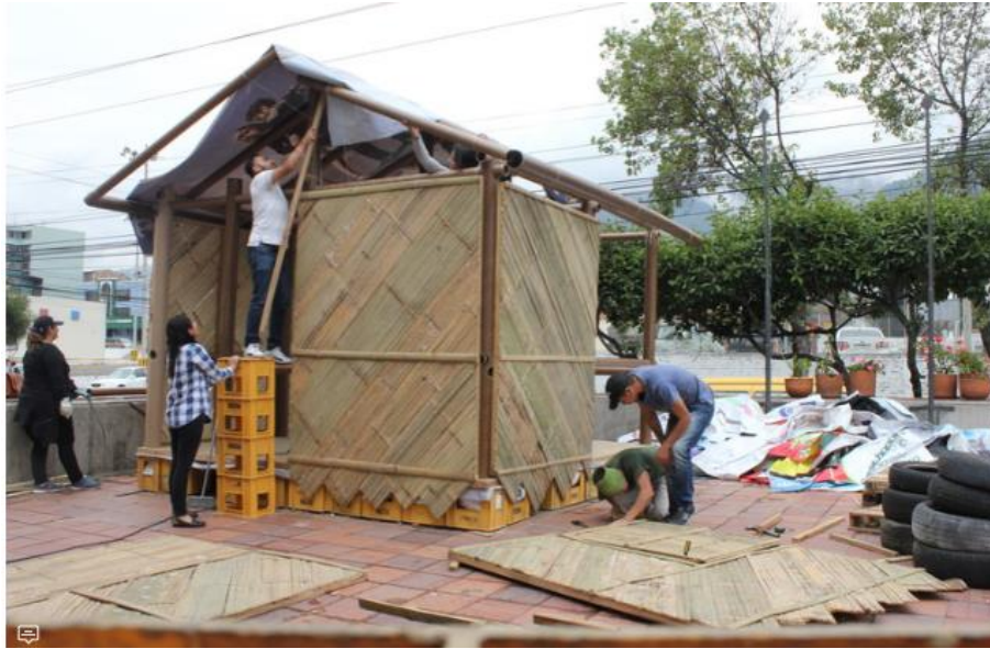
Fig. 21. Muros construido con cajas plásticas. Fuente: ArchDaily Colombia (2021)
