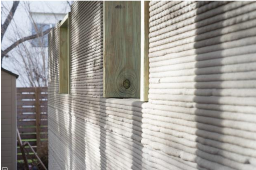
Fig. 20 Muros construido con material reciclado impreso en 3D. Fuente: ArchDaily Colombia (2021)
