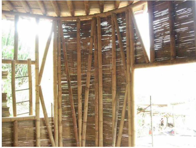
Fig.86. Pared con esterilla de guadua. Fuente: Gocksch (2012)
