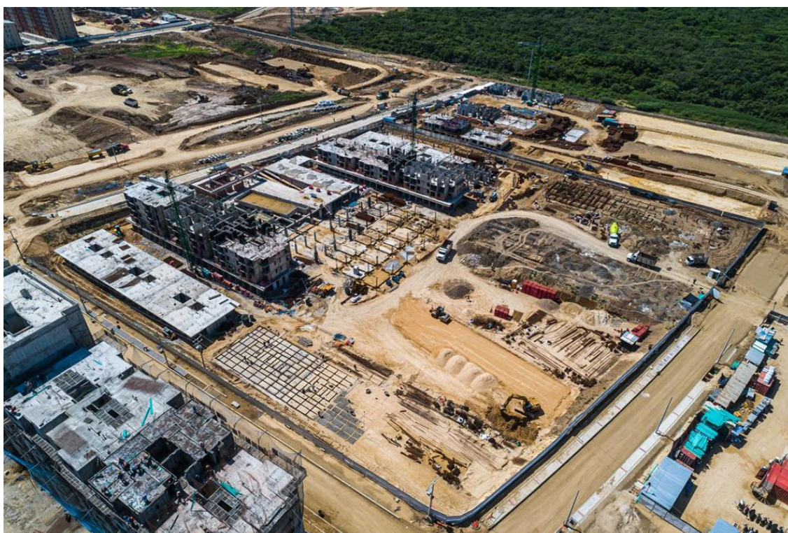
Ilustración 26. Proyecto de vivienda VIS construido bajo el concepto de construcción industrializada.
