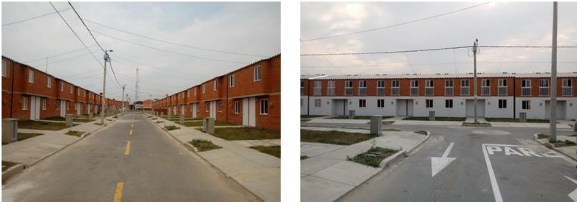
Ilustración 22. Proyecto de vivienda VIS en la ciudad de Santiago de Cali. Fuente: empresa ITC avalúos.
