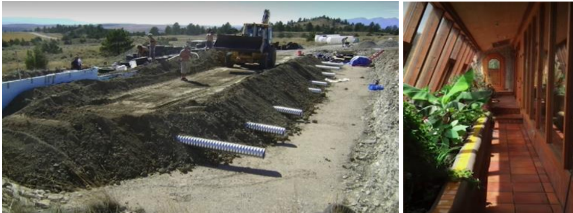
Figura 28. A la izquierda los tubos de ventilación en la parte posterior de la casa y a la derecha la ventilación de techo en el invernadero.
