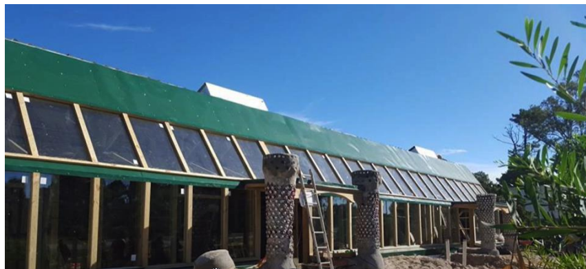
Figura 58. Uruguay: construcción de la primera escuela sustentable de Latinoamérica 01-26 febrero 2016.
