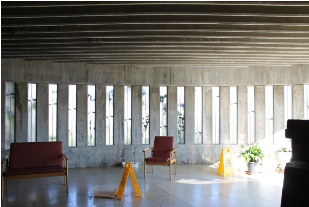
FIGURA 14: Huecos. Fuente: elaboración propia
