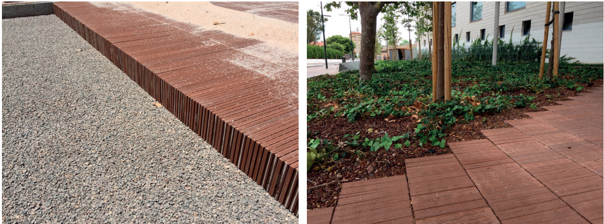
Figura 2 | Detalle de la instalación sobre base de gravilla del adoquín cerámico CerSUDS (izquierda) y aspecto de superficie acabada junto a zona ajardinada (derecha). (Elaboración propia).
