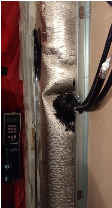
Sellado pase de instalaciones con pintura bituminosa. Fuente: Elaboración propia
