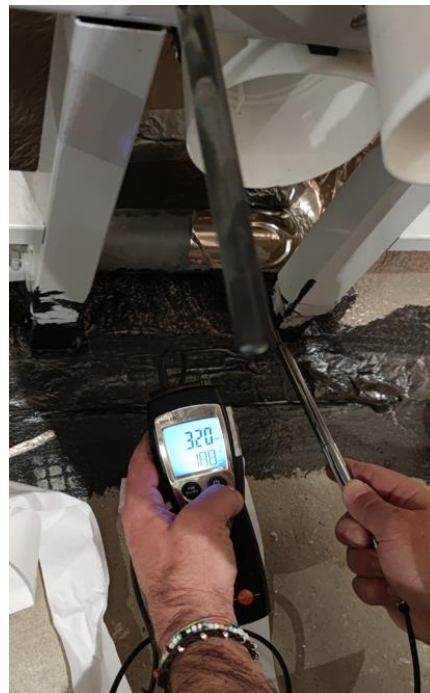
Control de infiltraciones en pase de instalaciones. Fuente: elaboración propia
