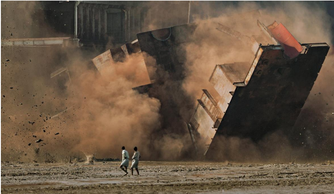
Figura 7.2.3. Caída de una sección cortada de un buque en Chittagong (Hettwer, 2020)
