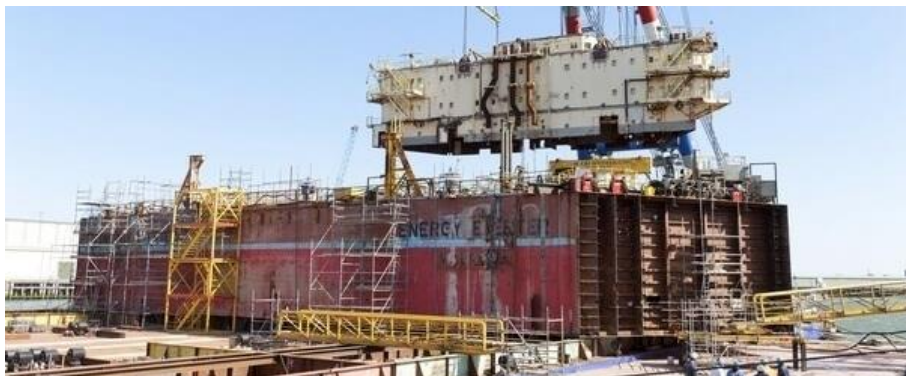
Figura 5.2.4. Buque siendo desguazado en las instalaciones de Damen Verolme Rotterdam B.V. ( DAMEN, 2022 )
