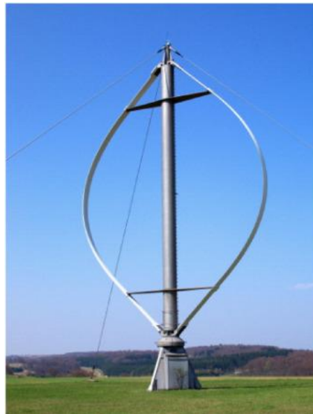
Figura 15: Aerogenerador de eje vertical. Fuente: [19]
