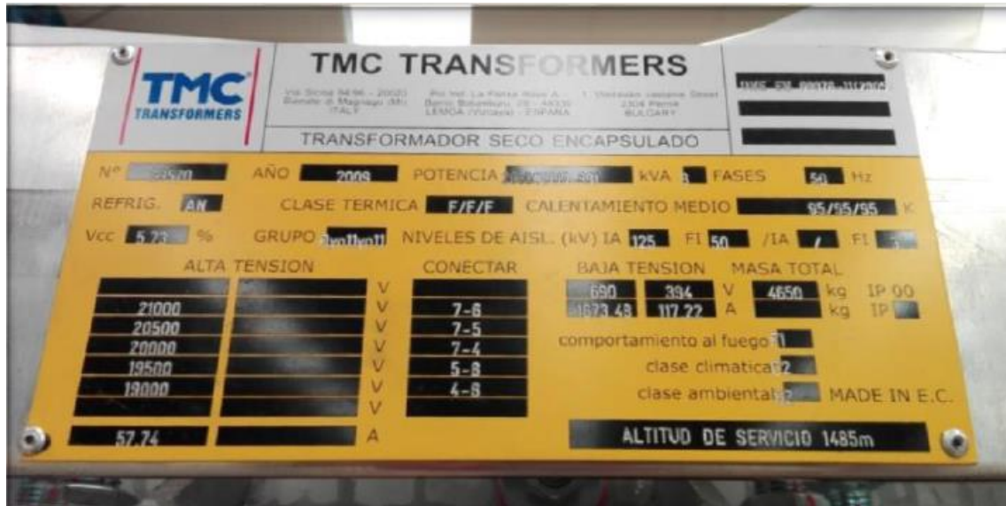
Figura 48: Características técnicas del transformador.
