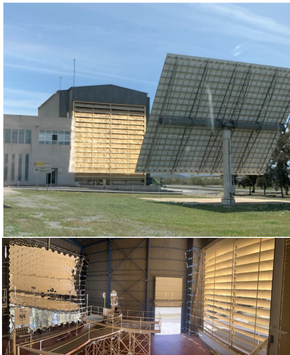
Figura 2: Imágenes de la instalación real usada como caso de estudio, cortesía de la PSA. Imagen superior: sistema captador y shutter. Imagen inferior: sistema concentrador y banco de ensayos.
